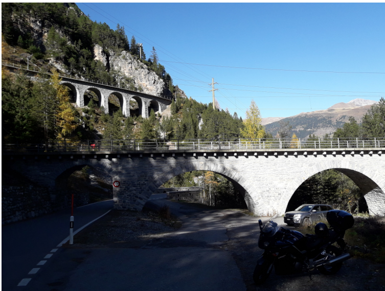
Die Bahnstrecke kommt scheinbar von allen Seiten
