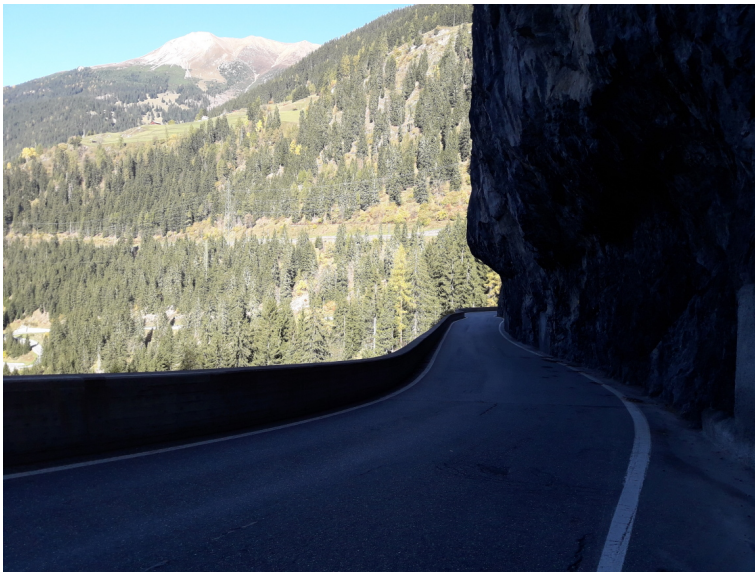
Die Straße ist förmlich in den Fels gehauen
