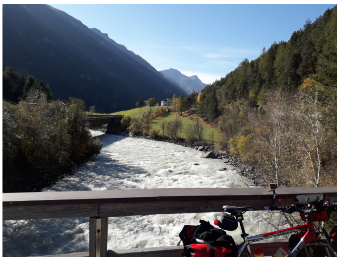
Brücke über den Inn
