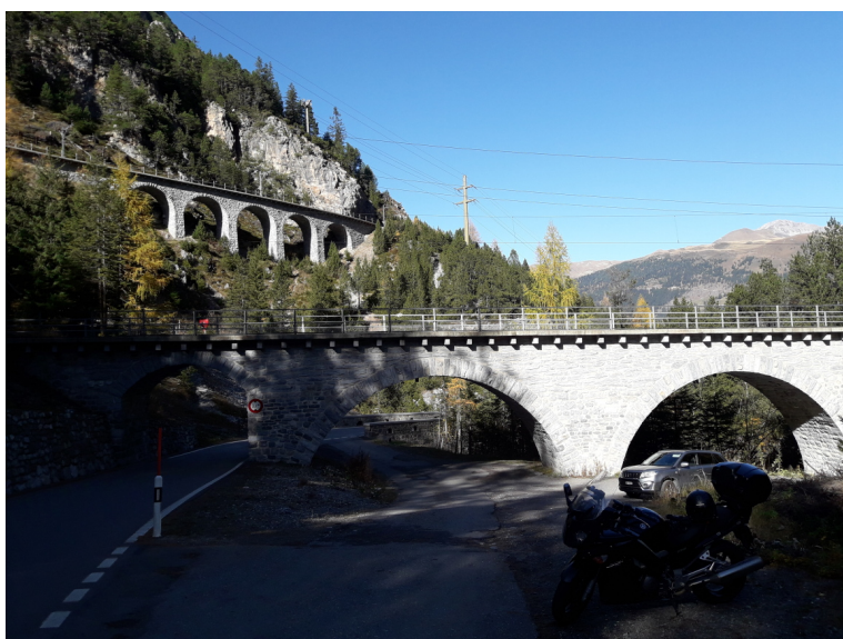
Die Bahnstrecke kommt scheinbar von allen Seiten
