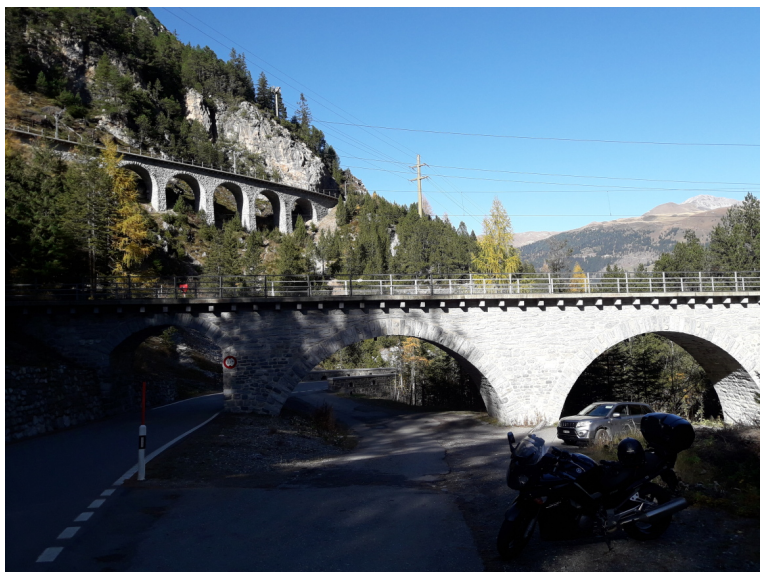
Die Bahnstrecke kommt scheinbar von allen Seiten
