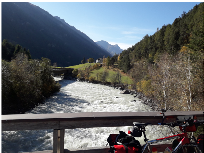
Brücke über den Inn
